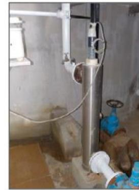
Figure 10. Traitement UV installé dans le bâtiment du réservoir
